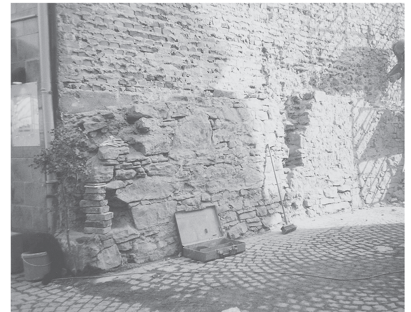
Die Mauer während der Sanierung 1998.
